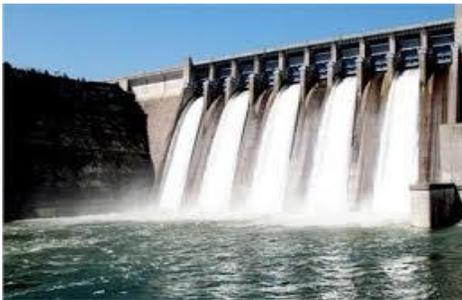
تستخدم السدود لتخزين المياه في خزان، وبالتالي يكتسب الماء طاقة وضع بسبب موضعه الجديد، ويحتوى السد على بوابات للتحكم في حركة الماء. عندما يتم فتح البوابات يتدفق الماء من أعلى إلى أسفل امام السد ليسقط على توربينات تدور بسبب سقوط الماء ثم تنتقل هذه الحركة إلى المولدات الكهربائية التي تحول طاقة الحركة إلى طاقة كهربائية.
