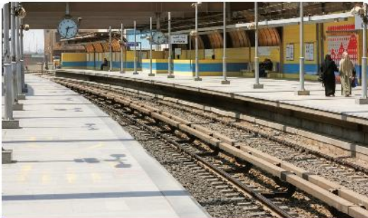
محطة مترو في القاهرة
