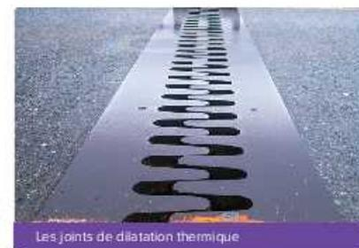
La plupart des ponts sont en acier et en béton. Lorsque ces matériaux sont exposés à des températures chaudes et froides, ils se dilatent et se contractent. Les ingénieurs utilisent des diverses techniques lors de la conception des ponts pour garantir leur sécurité au fil du temps.
