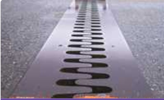
وصلات التمدد الحراري
