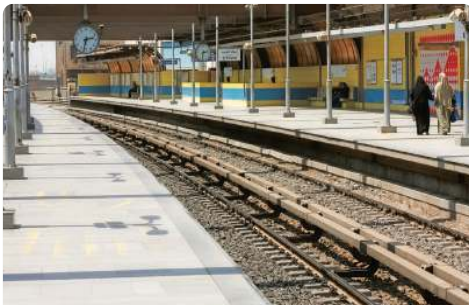
محطة مترو في القاهرة
