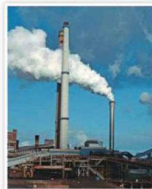
Fig. (3-18) : Le dioxyde de carbone se produit des installations industrielles.
