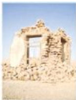
Une maison détruite
