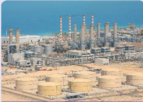
محطة تحلية المياه
