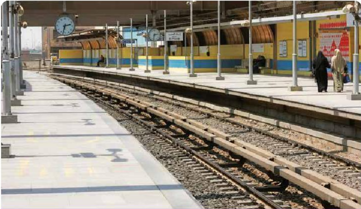
محطة مترو في القاهرة
