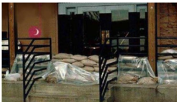
**Sacs de sable:** les gens mettent des sacs de sable autour de leur propriété pour empêcher la crue des eaux d'entrer. Les eaux de crue en mouvement sont détournées autour des sacs de sable.
