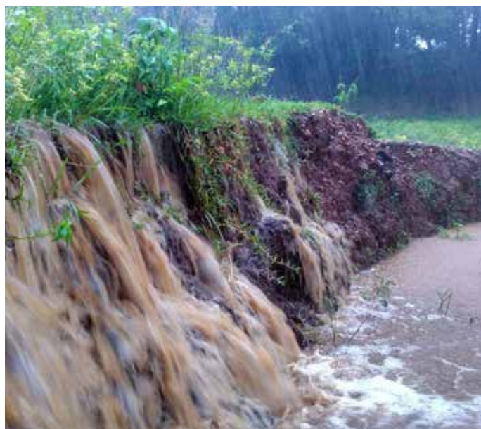
Eau et boue coulant
