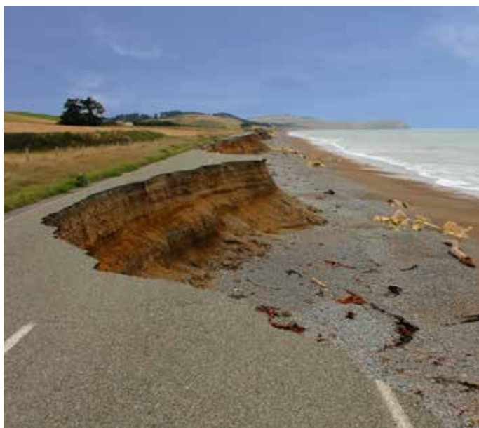
Route érodée près de l'océan
