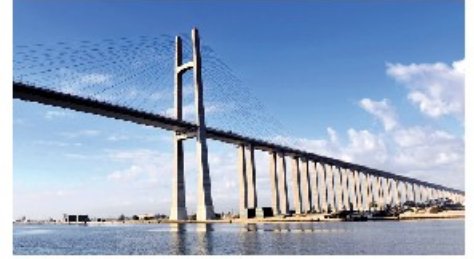
نستخدم الصلب لبناء الجسور
