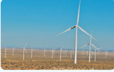
محطة جبل الزيت
