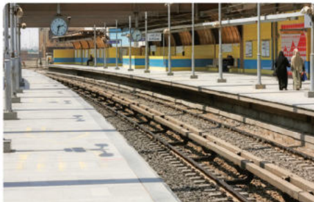
محطة مترو في القاهرة
