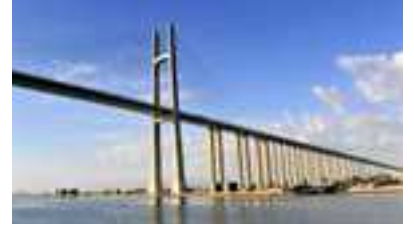
نستخدم الصلب لبناء الجسور
