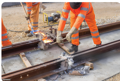
شكل (7) لحام القضبان بتفاعل الترميت
